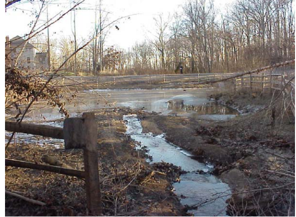
Figure M5.1 Sediment delta.
